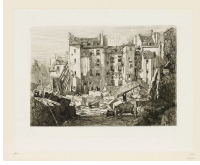
↗ Maxime Lalanne (*1827 - † 1886), Radierer Abbrucharbeiten für den Durchbruch der Rue des Écoles, 1862
